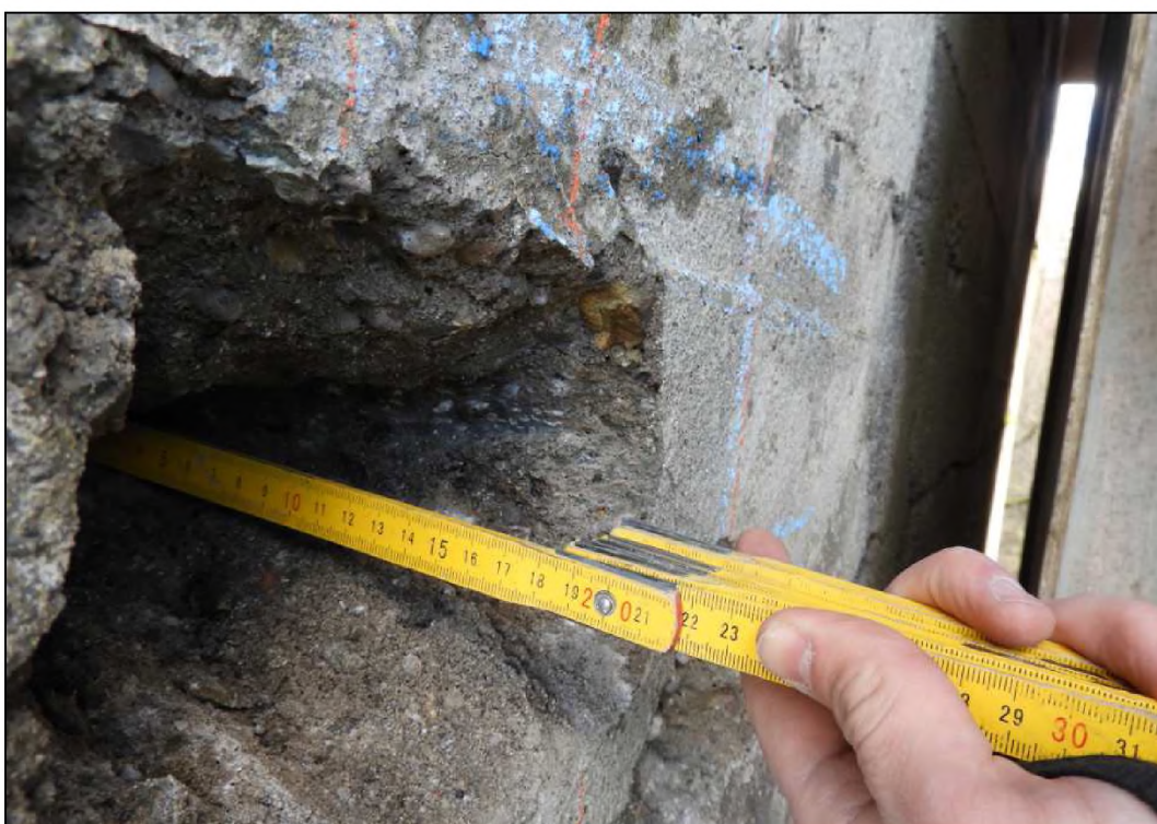
Obrázek 19 - sonda S1, sonda do hloubky 200 mm, nebyla zjištěna žádná výztuž
