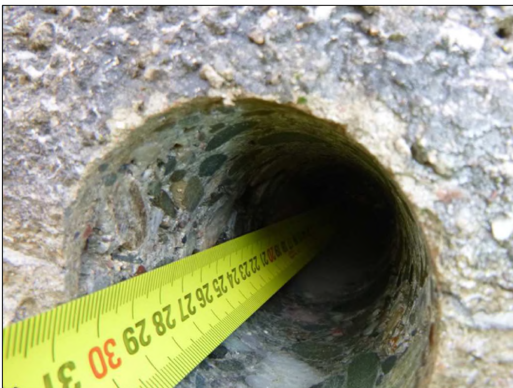
Obrázek 28 – TRHLINA T2, pohled do vrtu T2, hloubka trhliny 305 mm
