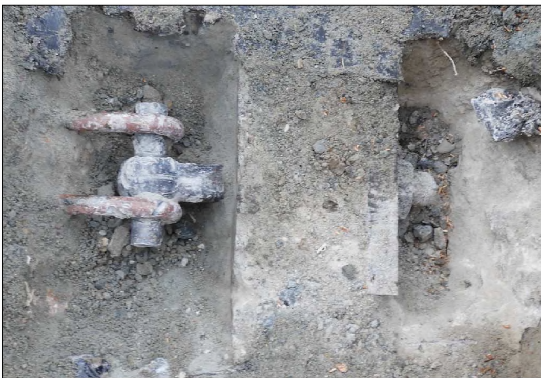
Obrázek 13 – sonda K1, kotevní šroub 2, bez koroze
