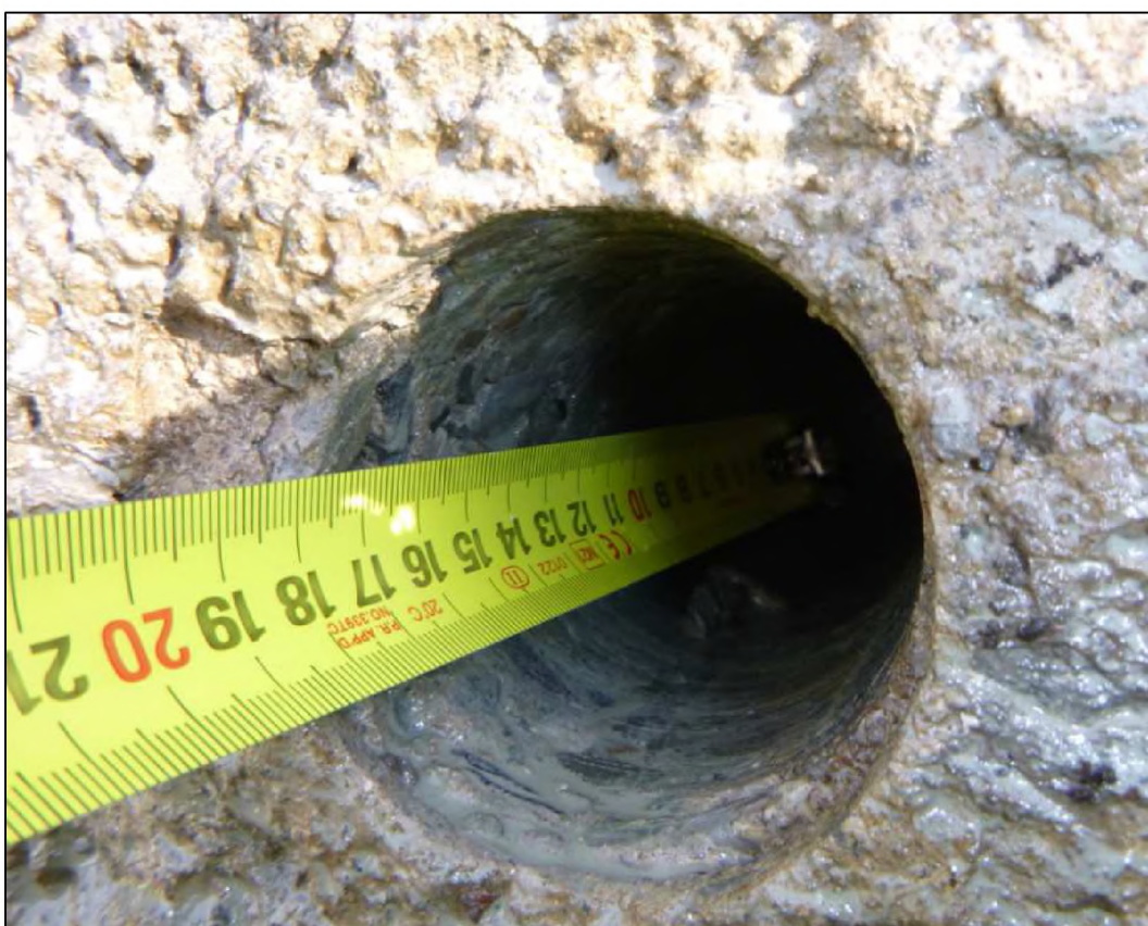
Obrázek 34 – pohled do vrtu T4, hloubka trhliny 180 mm
