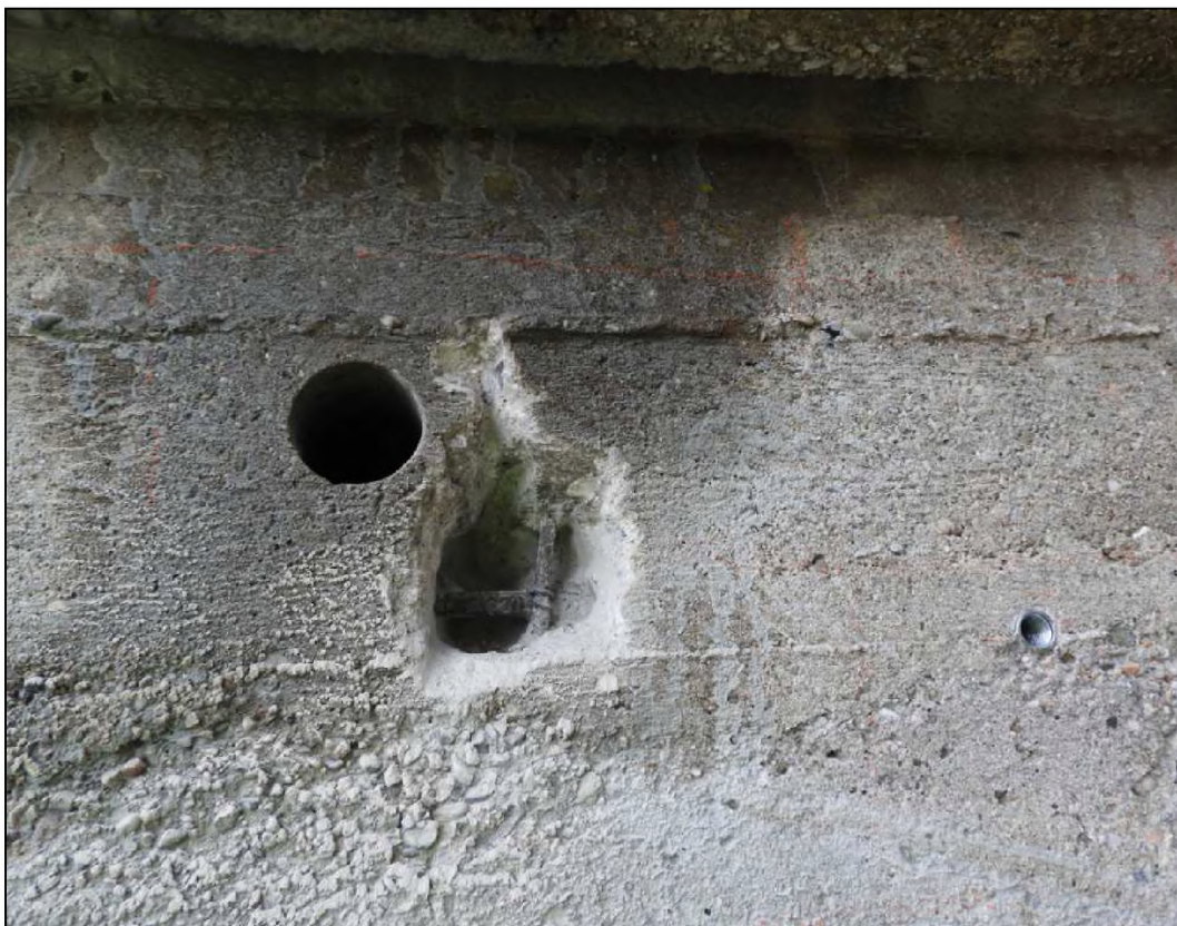
Obrázek 20 – sonda S2 – úložný práh, pod okapní římsou vlevo
