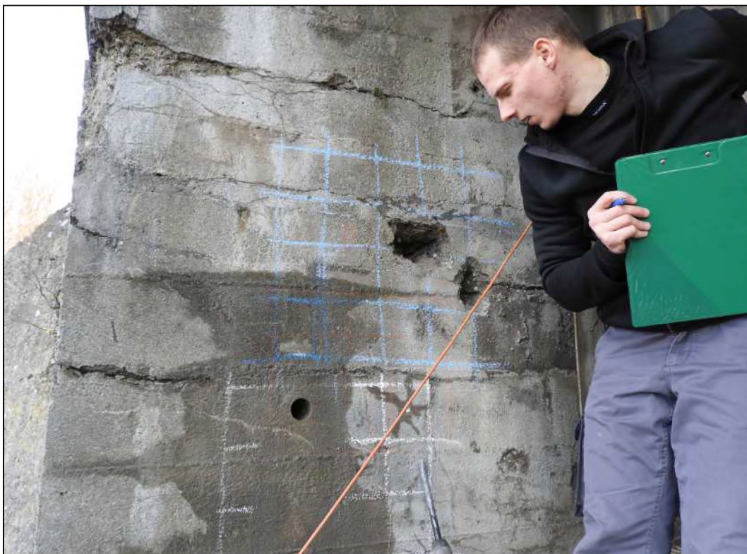
Obrázek 18 – sonda S1, ověřující sondy v závěrné zídce vlevo
