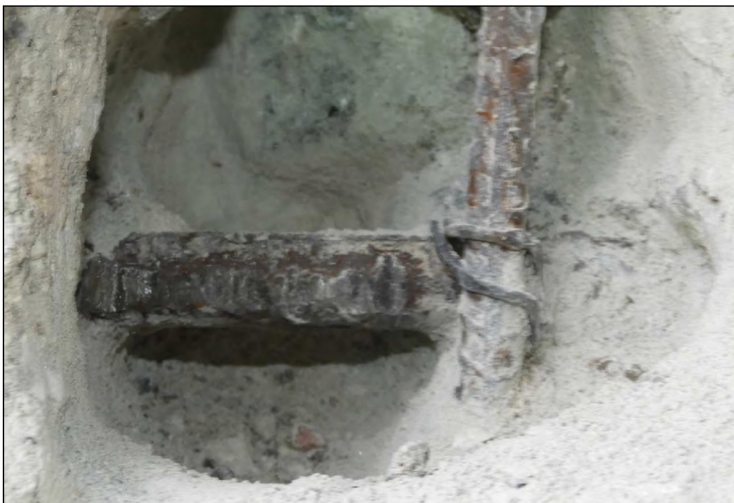
Obrázek 21 – sonda S2 – vodorovná výztuž Ø 12 mm, svislá výztuž Ø 8 mm, výztuž typu 10 335 (J), bez korozních úbytků, krytí 70 mm
