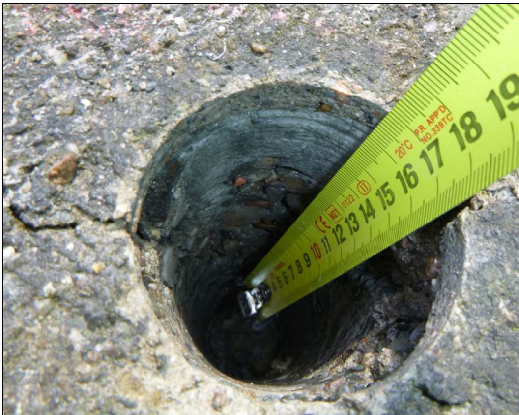
Obrázek 25 – TRHLINA T1, pohled do vrtu, hloubka trhliny 170 mm
