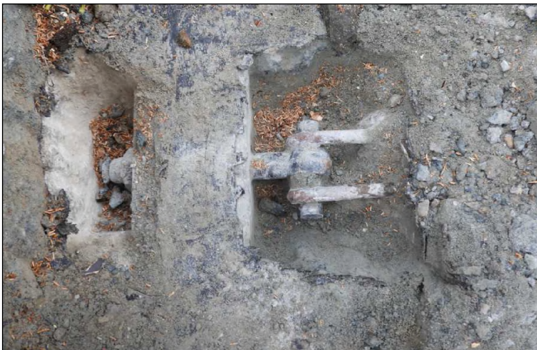
Obrázek 12 – sonda K1, kotevní šroub 1, bez koroze
