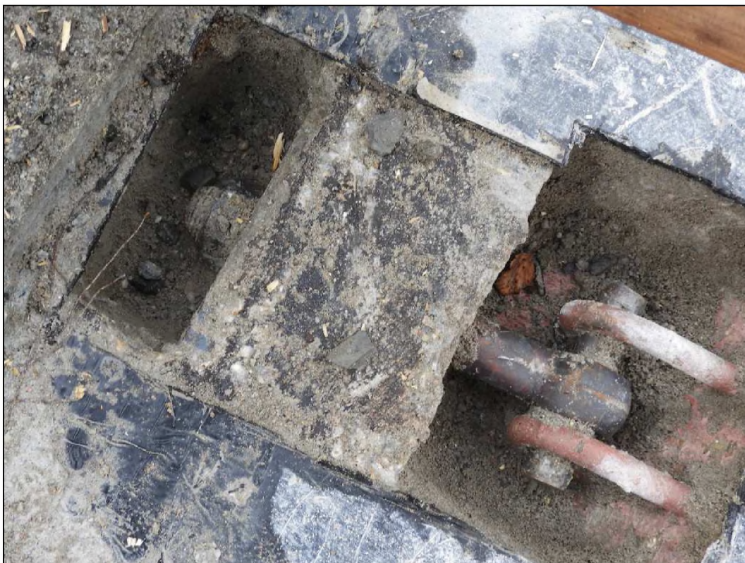
Obrázek 16 – sonda K2, kotevní šroub 2, bez koroze
