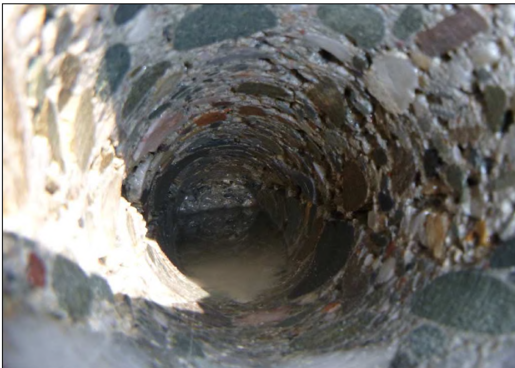
Obrázek 27 – TRHLINA T2, pohled do vrtu T2, hloubka trhliny 305 mm
