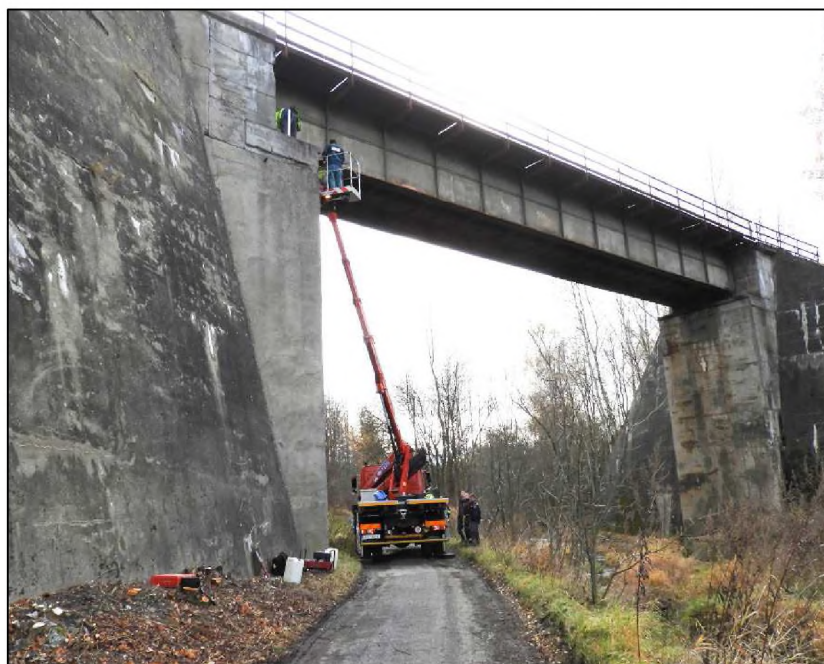
Obrázek 17 – zpřístupnění konstrukce pomocí plošiny
