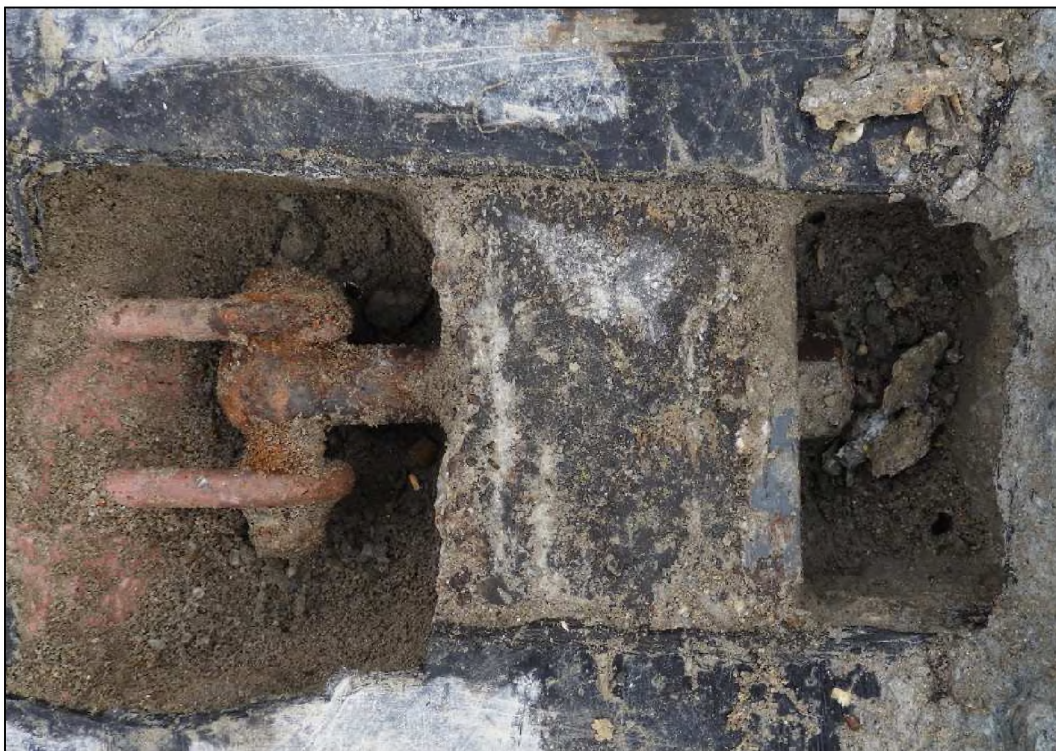
Obrázek 15 – sonda K2, kotevní šroub 1, mírná povrchová koroze, bez korozního oslabení
