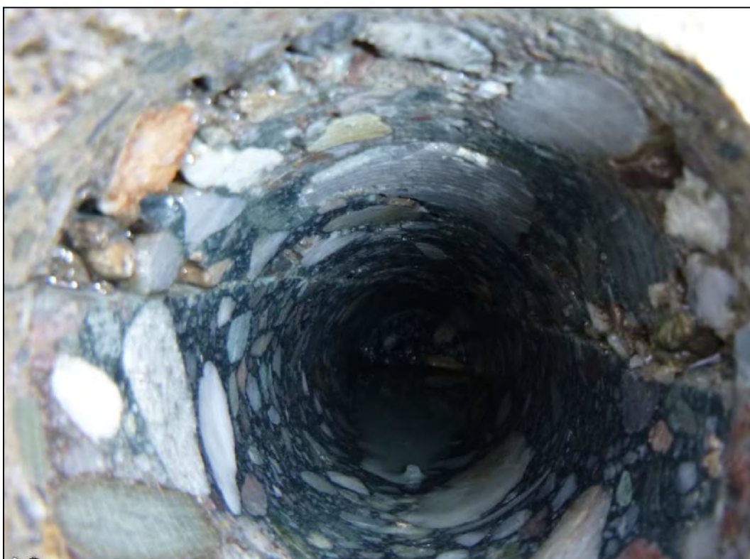
Obrázek 30 – TRHLINA T3, pohled do vrtu
